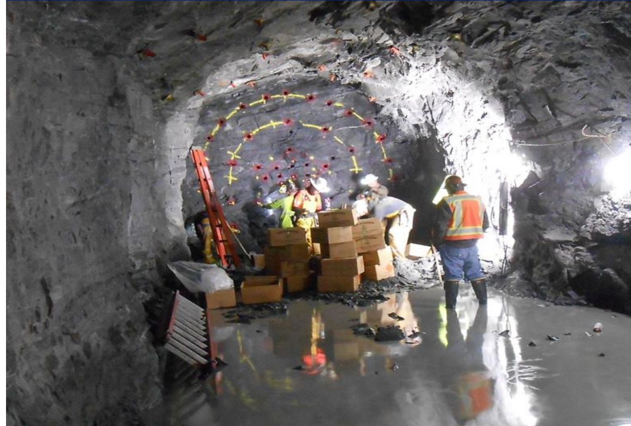
Drill & Blast (D&B)
